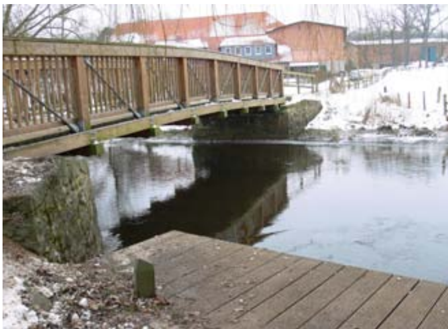
Fotografía 6. Construcción de un puente de madera sobre un río para conectar las pistas para ciclistas y paseantes y de un muelle para canoas (Alemania)
