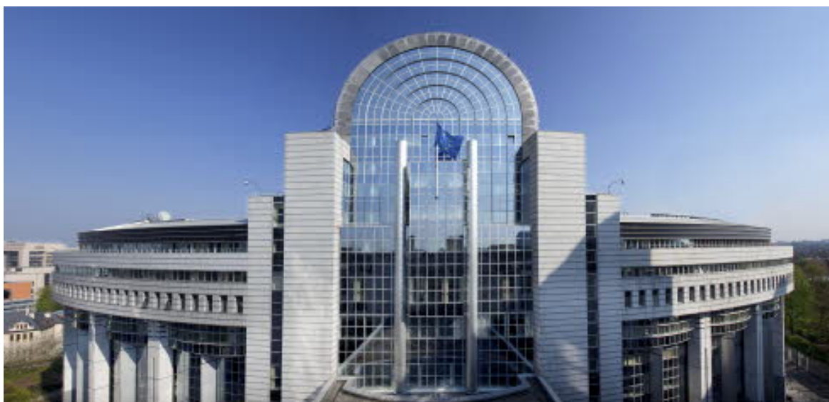
Budynek Paul-Henri Spaak, Bruksela
