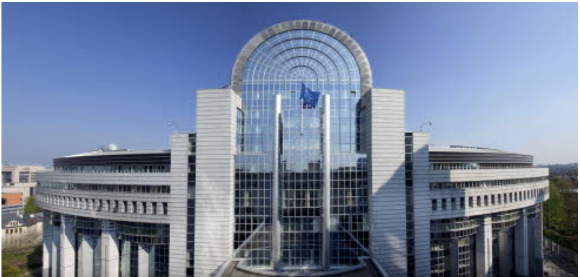
Paul-Henri Spaak-byggnaden i Bryssel.
