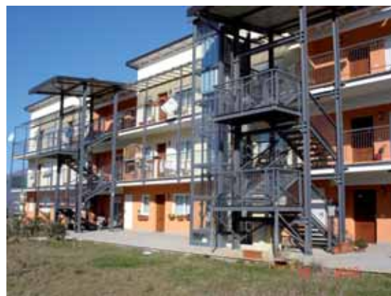
Nově postavené seismicky odolné budovy v italské L'Aquile.
