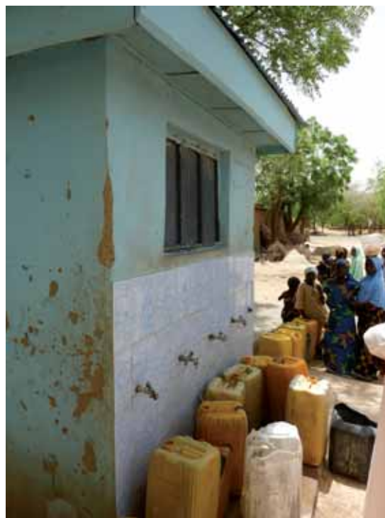
Pawilon zaopatrzenia w wodę, Jigawa, Nigeria
