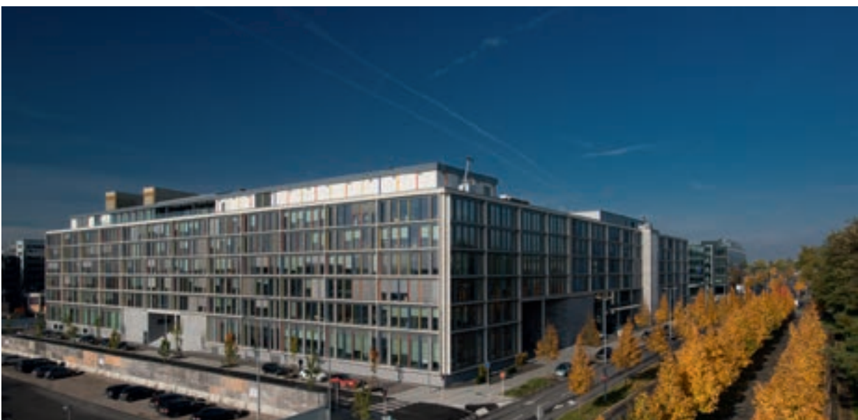
Imagen del edificio K3, parte de la sede del Tribunal en Luxemburgo.
