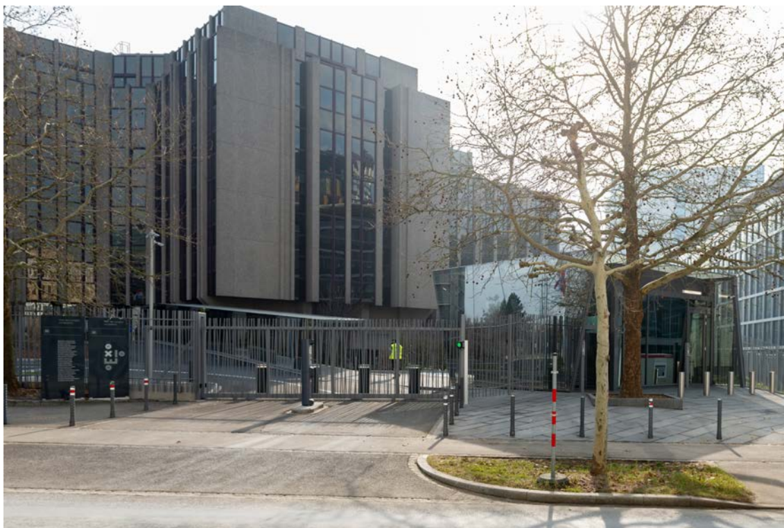
Het hoofdgebouw van de ERK "K1" en het nieuwe beveiligingscentrum aan de rue Alcide De Gasperi, Luxemburg.
