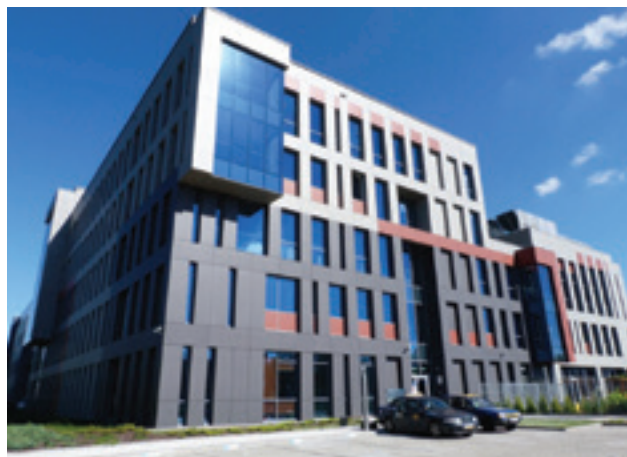
Bâtiment «Delta» cofinancé par le FEDER dans le parc technologique de Wrocław. Architecte: Anna Kościuk.
