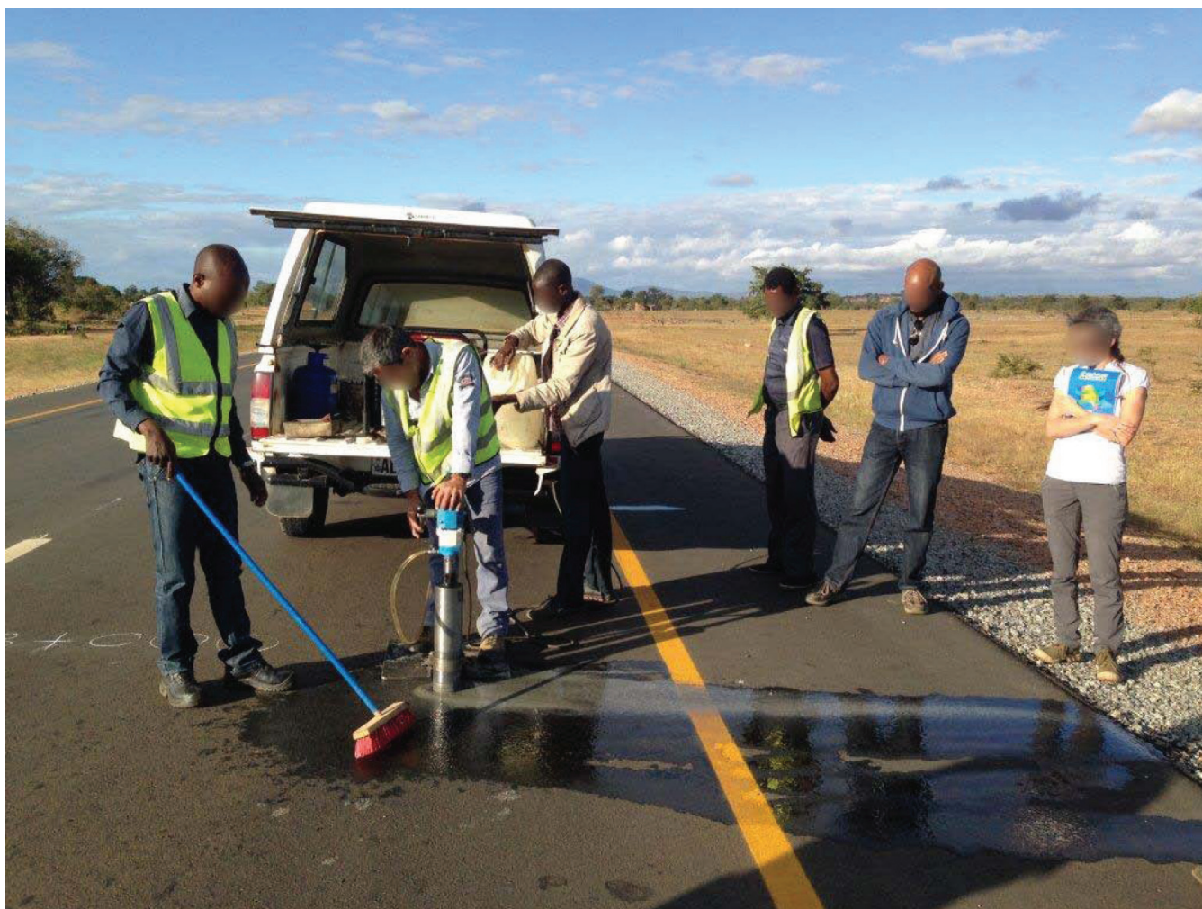
Okvir. 3. – Revizori ispituju točnost mjerenja debljine ceste za plaćanje povezano s jednim cestovnim projektom u Zambiji
