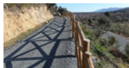
EU's støtte til infrastruktur i landdistrikterne har potentiale til at give væsentlig mere valuta for pengene (nr. 25/2015)
