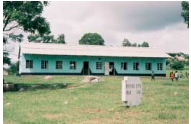
Se construyeron numerosas escuelas primarias
