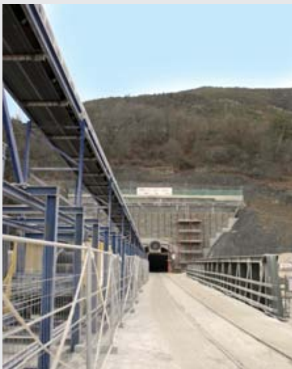
Foto 5 - Indgang til forsøgstunnellen i forbindelse med basistunnellen under Brenner ved Fortezza
