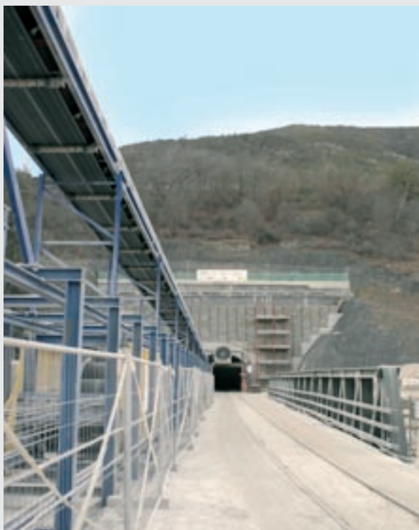
Φωτογραφία 5 – Είσοδος της διερευνητικής σήραγγας για τη βασική σήραγγα Brenner στη Fortezza
