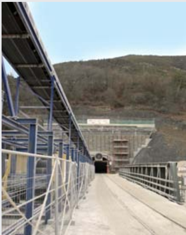
Foto 5. Sissepääs Brenneri baastunneli uurimistunnelisse Fortezza lähedal
