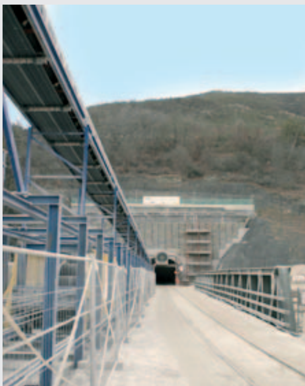
Fotografia 5 – Vstup do prieskumného tunela k tunelu na úpätí Brenneru vo Fortezze
