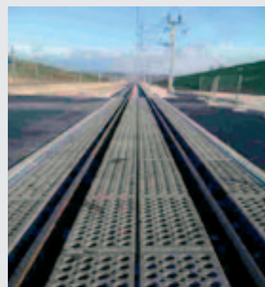
Fotografia 3 – Zatiaľ nevyužívané nové trate na medzinárodnom úseku Perpignan-Figueras
