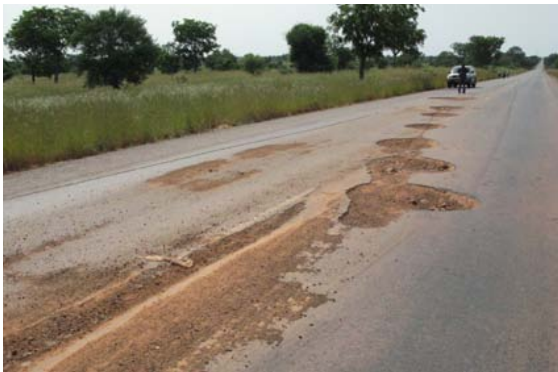
ASSENZA DI MANUTENZIONE ORDINARIA
