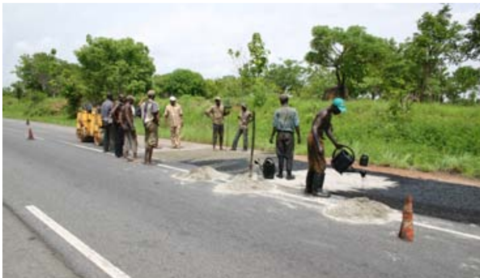
MANUTENZIONE STRADALE ORDINARIA
