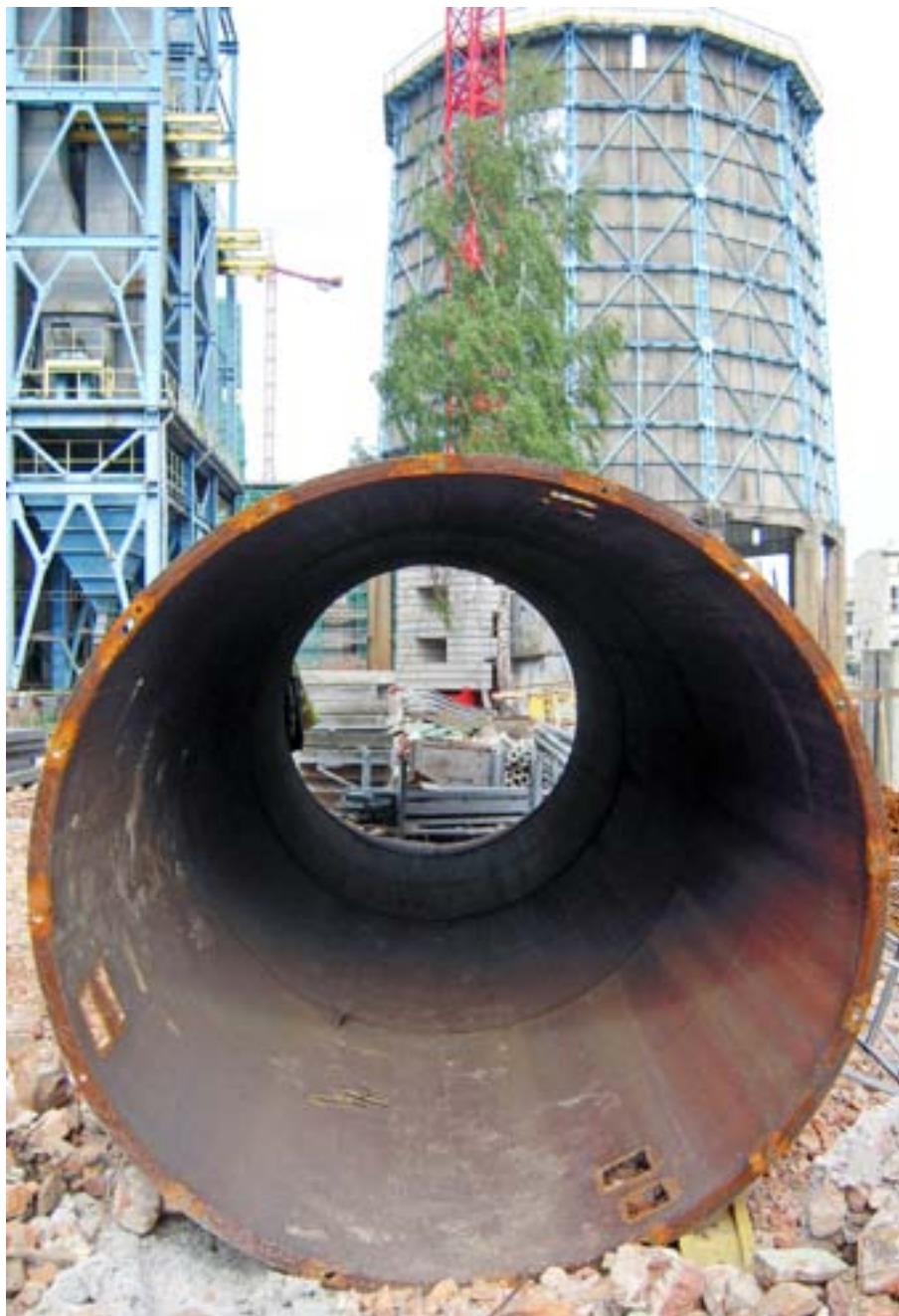
1. fénykép. Egy bezárása után művészeti és kulturális központtá alakított erőmű városképi jelentőségű belvárosi tornyának felújítása és átalakítása (Łódź, Lengyelország)
