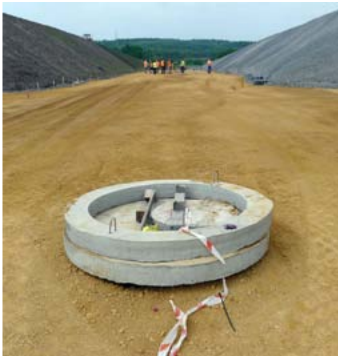
4. fénykép. Utak és közművek építése egy korábbi szénbánya meddőhányóinak helyszínén (Jaworzno, Lengyelország)
