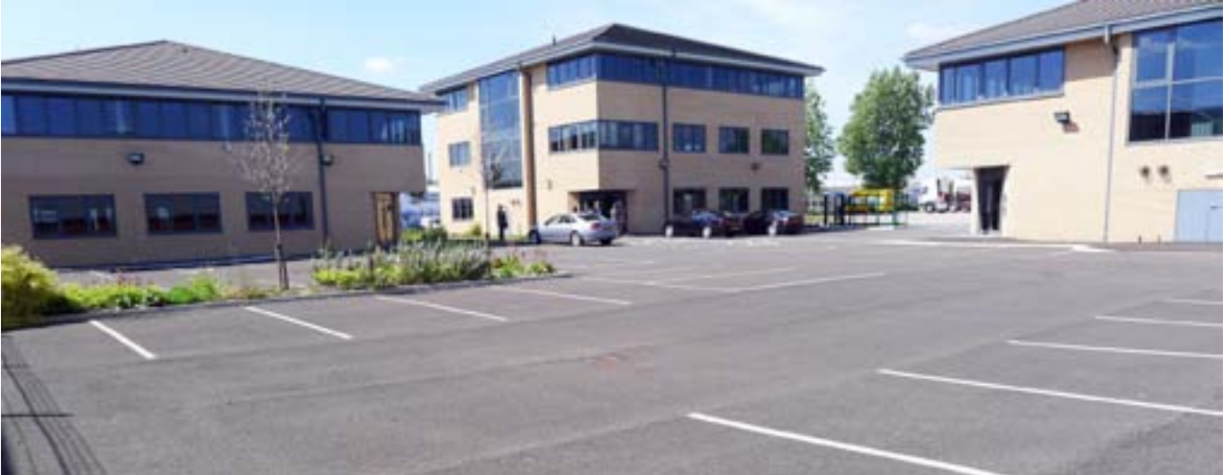
Ritratt 6 – Uffiċċji lesti biex jintużaw, mibnija fuq is-sit ta’ dak li qabel kien Impjant tas-Sustanzi Kimiċi (Widnes, ir-Renju Unit)
