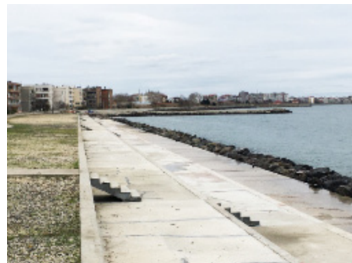
Küstendamm zur Vermeidung der Überflutung eines Wohngebiets. Der Damm kann künftig erhöht werden, falls die Hochwassergefahr steigt (Bulgarien).
