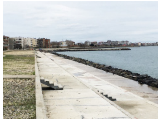
Kaldakindlustused elamupiirkondade üleujutamise vältimiseks. Tulevikus, kui üleujutusohu suureneb, saab kaldakindlustuse kõrgemaks ehitada (Bulgaaria)
