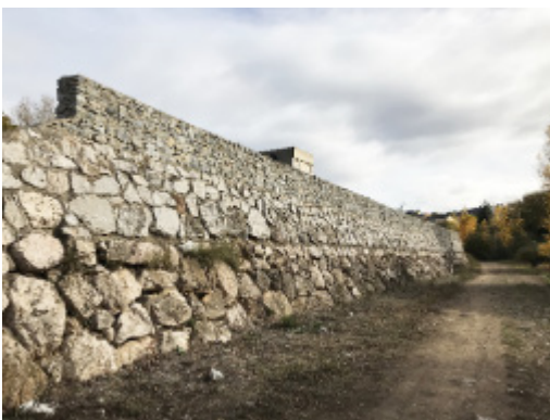
Üleslaotud 200 m pikkune müür kahe jõe ühinemiskohas, kus varem on esinenud üleujutusi (Hispaania)
