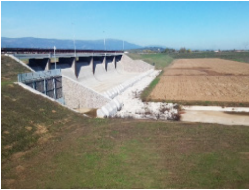
Tühja veehoidlat kasutatakse ajutise veehoidlana, et vähendada allavoolu asuvate linnade üleujutamise riski. 110 hektarit veehoidlast kasutatakse ka põllumajanduse otstarbel (Itaalia)
