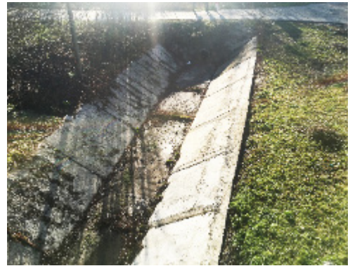
Rijeka nakon provedbe projekta
