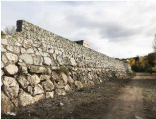
Wzniesiony mur o długości 200 m u zbiegu dwóch rzek, w miejscu, gdzie w przeszłości występowały powodzie (Hiszpania)
