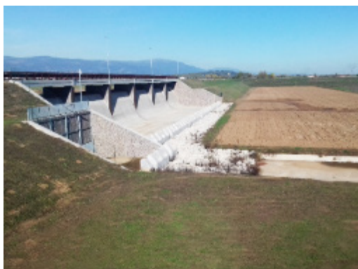
Suchy zbiornik wykorzystywany do tymczasowego magazynowania wody w celu ograniczenia ryzyka zalewania miast położonych w dół biegu rzeki. Zbiornik o powierzchni 110 hektarów jest także wykorzystywany na potrzeby rolnictwa (Włochy)
