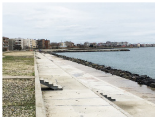
Wał nadbrzeżny w celu zapobiegania zalewaniu dzielnicy mieszkaniowej. Wysokość wału można zwiększać w przyszłości, jeśli wzrośnie zagrożenie powodziowe (Bułgaria)
