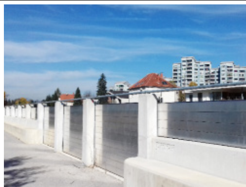
Wał rzeczny z usuwanymi ścianami umożliwiający kontrolowane zalewanie jednego z brzegów rzeki w celu ochrony przeciwnego, gęsto zaludnionego brzegu (Słowenia)
